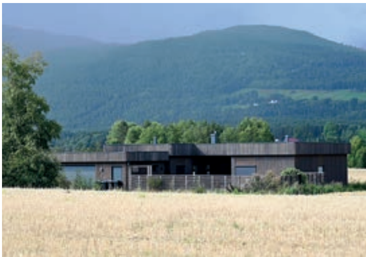
SPENNANDE HUS: Eivind Myhre og Sveinung Lønnestad sette opp huset til Frid Berge og Frank Rosell i 2016. Det var eit spennande hus å bygge. FOTO: Bø blad, arkivfoto
